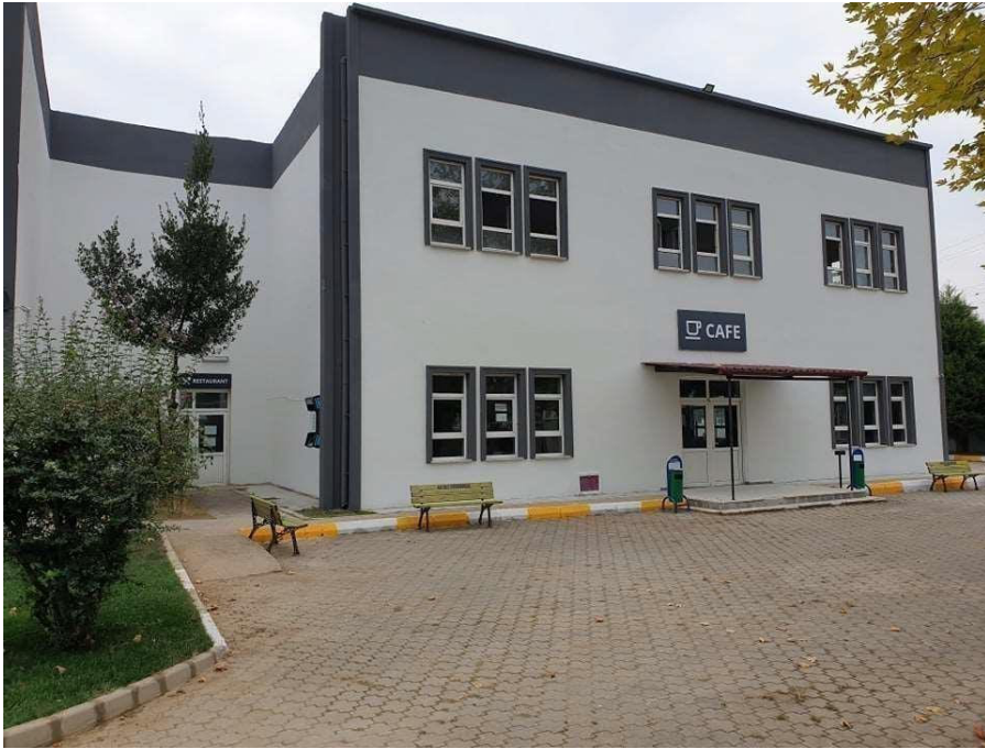
Yemekhane ve Kantine Binası
