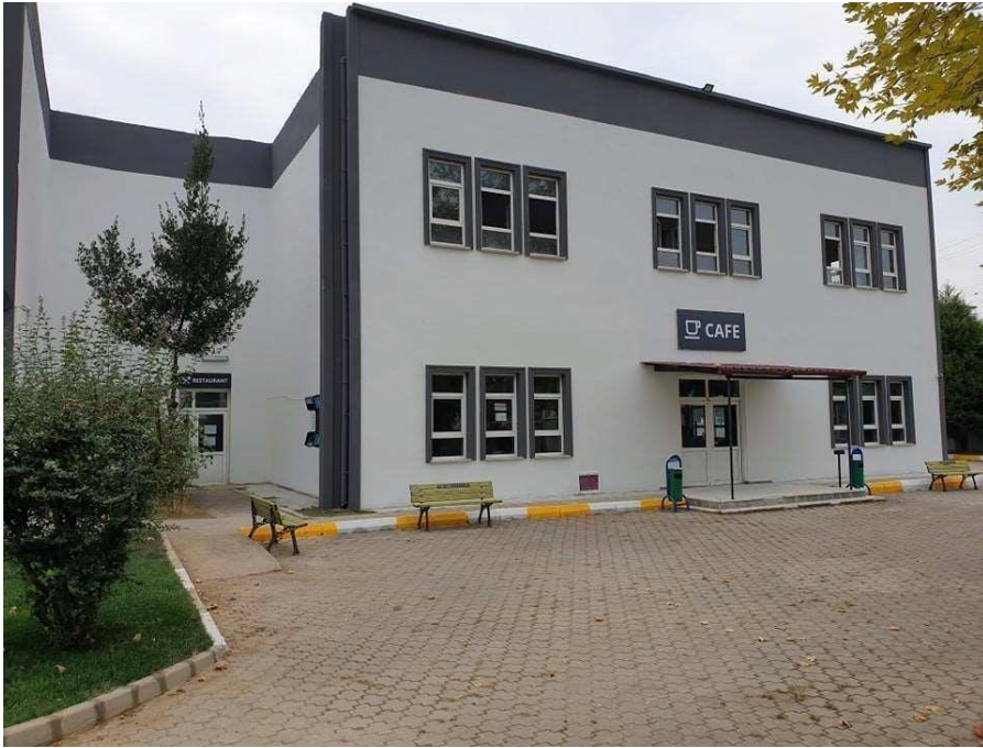
Yemekhane ve Kantine Binası
